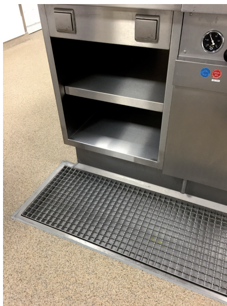
Abb. 2: Beispiel für eine tritt- und kippsichere, belastbare und bodengleiche Ablauföffnung
