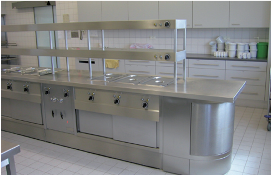
Abb. 5: Quellluftauslass in den Küchenblock integriert (Stirnseite)
