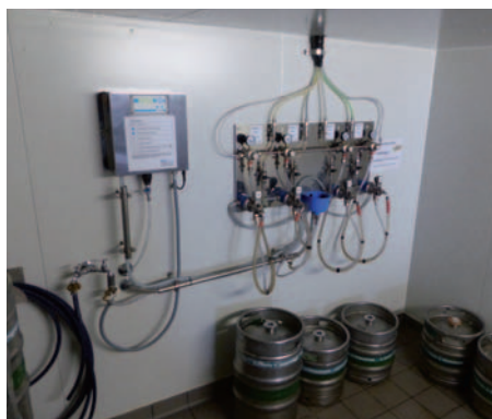
Abb. 9: Automatisches chemisches Reinigungsgerät für Leitungen (Dosiervorrichtung und Steuereinheit)
