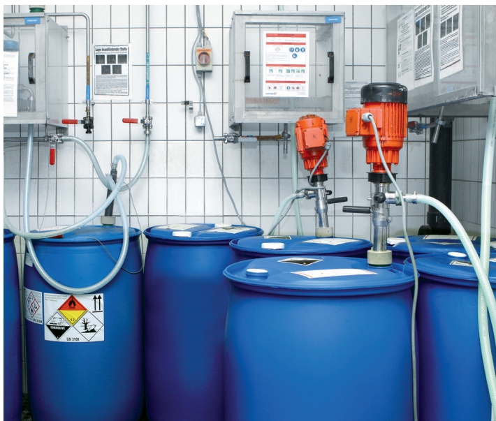
Abb. 5: Fässer mit PES-Konzentrat im Dosierraum ohne feste Verrohrung, Jedermann-Verlag GmbH
