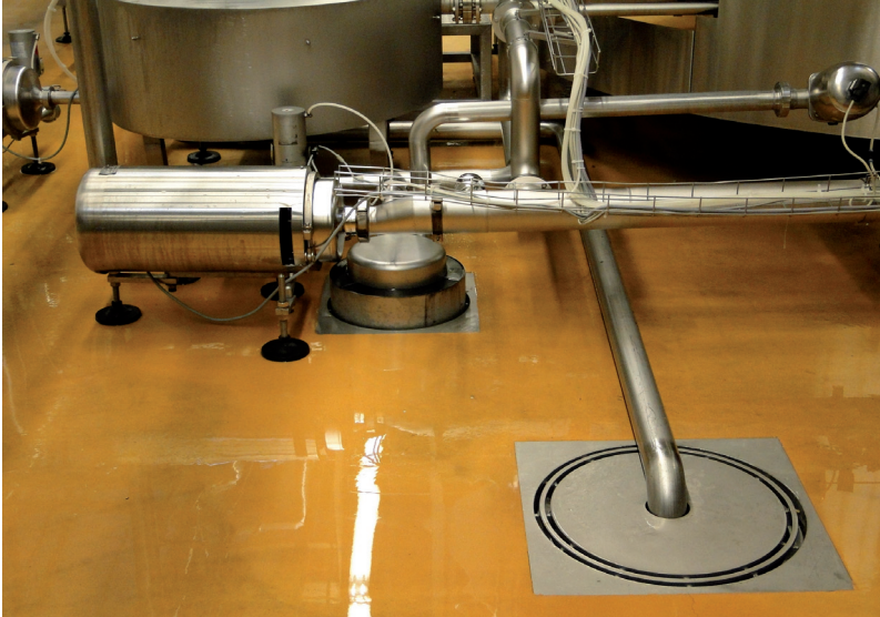
Abb. 7: Geschlossene Brauchwasserführung über Verrohrung, die direkt in den Gully geführt wird.
