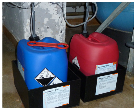
Abb. 4: Dosierung über Sauglanze
