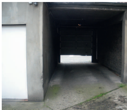
Abb. 1: Vom Fahrzeug aus mittels Fernbedienung bedienbares Rollltor
