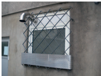
Abb. 7: Durch Gitter geschütztes Fenster
