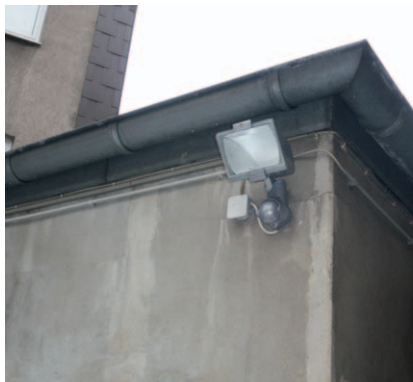
Abb. 2: Schwer zugänglich angebrachte Außenbeleuchtung mit Helligkeitssensor und Bewegungsmelder
