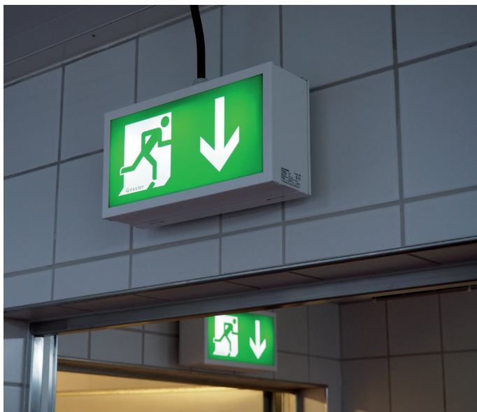
Abb. 6: Beleuchtete Kennzeichnung im Fluchtwegbereich
