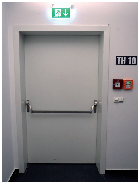
Abb. 4: Fluchttür mit Panikstange
