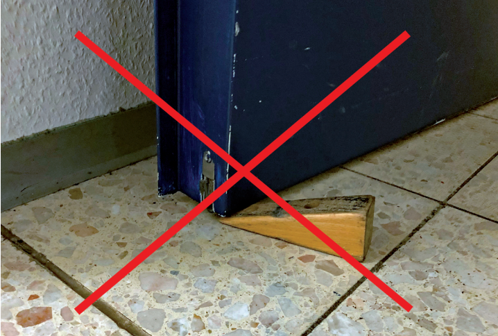
Abb. 13: Verbotenes Verkeilen einer Brandschutztür
