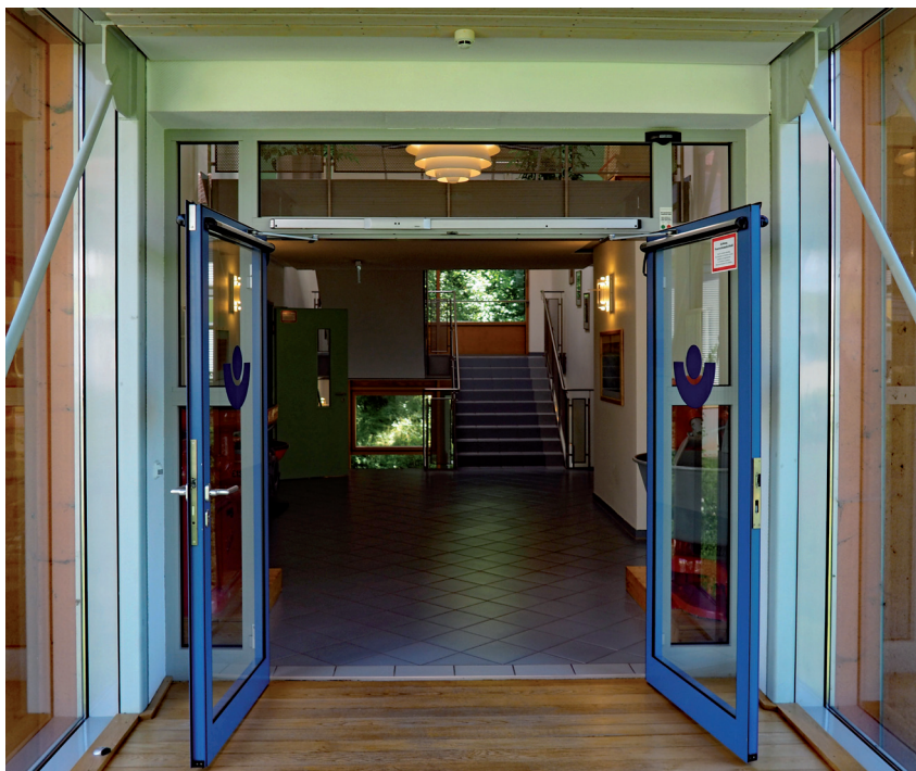
Abb. 12: Zweiflügelige Feuerschutztür mit Rauchsensor und automatischer Türschließung.
