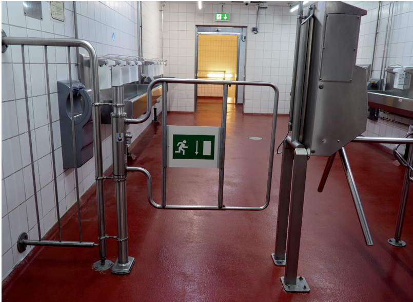
Abb. 5: Hygieneschleuse mit Fluchttür
