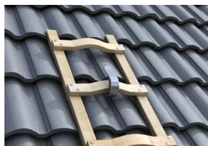
Abb. 66 Einhängen der Dachauflegeleiter
